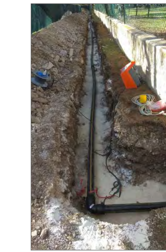
FOTO N.6 (posa tubazione interrata)
